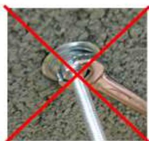
Remplace la rondelle + l'écrou
