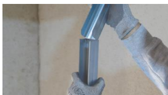
Insérer le clip'in dans le montant PSP
